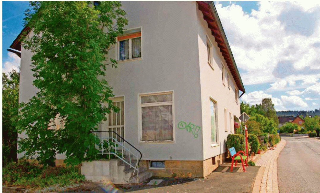
In dem ehemaligen Haushaltswarengeschäft der Familie Franke sind noch die Schaufenster vorhanden. Dort könnte ein Dorfladen eingerichtet werden.
