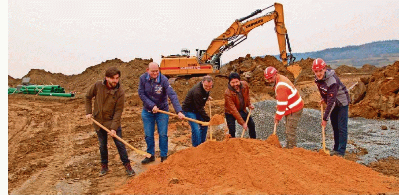
Beim obligatorischen Spatenstich für das neue Baugebiet: (von links) Reimund Waadt vom Pongratz-Ingenieurbüro, Thomas Silbermann vom Bauamt der VG Mistelgau, Projektleiter Erwin Schreiber von der KFB, Bürgermeister Sven Ruhl, Polier Matthias Mayer und Markgraf-Bauleiter Dominik Schultes. Foto: Dieter Jenß
