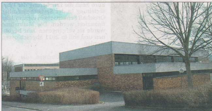
Das Schulgebäude und die Mehrzweckhalle werden für knapp eine Million Euro generalsaniert. Foto: Jenß
