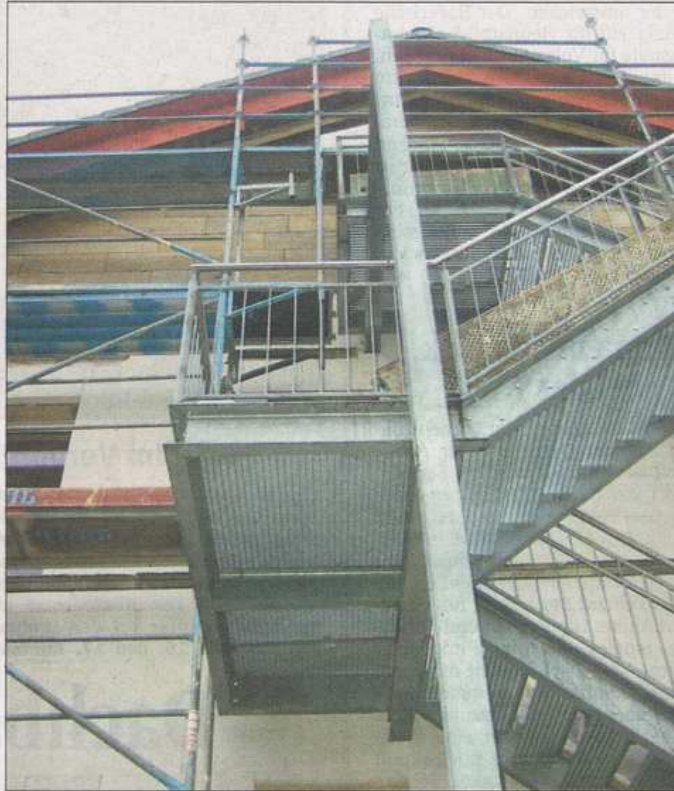
Die energetische Sanierung der Kindertagesstätte der Arbeiterwohlfahrt geht zügig voran: Wärmedämmung und Dacherneuerung sind so gut wie abgeschlossen. Foto: Buchwald
