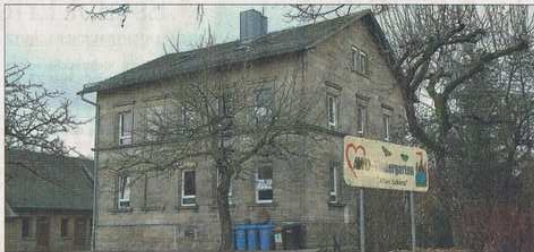
Der Gemeinderat Glashütten hat grünes Licht für die insgesamt 1,1 Millionen Euro teure Sanierung der Mehrzweckhalle, des Schulgebäudes sowie des Kindergartens (Bild) gegeben. Foto: Jenß
